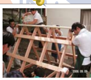
会館補修(三角屋根) 江東YMCA幼稚園のシンボルである「三角屋根」を保護者と協力して「建て替え」!
