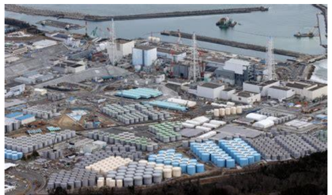
処理水放出が始まった福島第一原発エリアのタンク群
