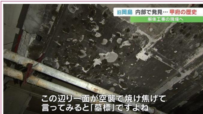
太平洋戦争末期の昭和 20 年、1945 年 7 月に起きた甲府空襲。アメリカ軍の爆撃で甲府の市街地は一面焼け野原となり、1127 人が命を落としました。凄惨な空襲に耐えた数少ない建造物のひとつがこの旧岡島です。「鉄筋コンクリートという不燃構造だったから（残った）」黒々とした焦げ跡が、火の手の激しさを物語っています。
