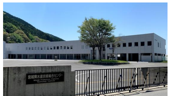
↓新しく建設された県水産試験場（渡波）
