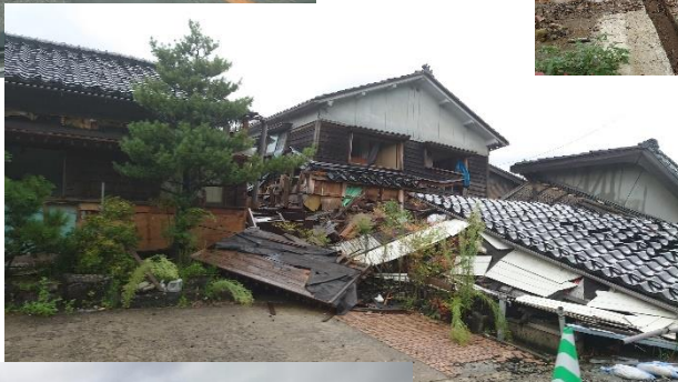
倒壊したまま放置されている 家屋が多い
