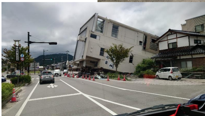
報道もされた、輪島市中心街のビルの倒壊
